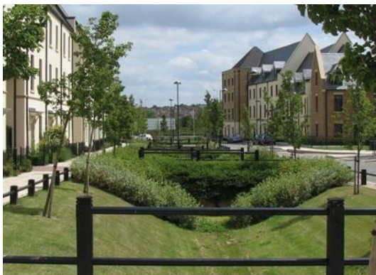
Hình: dải phân cách thiết kế dạng kênh trữ nước dự phòng
