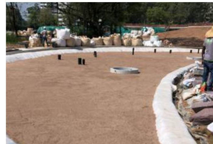
Hình 5.7: Lắp đặt các lớp lọc
