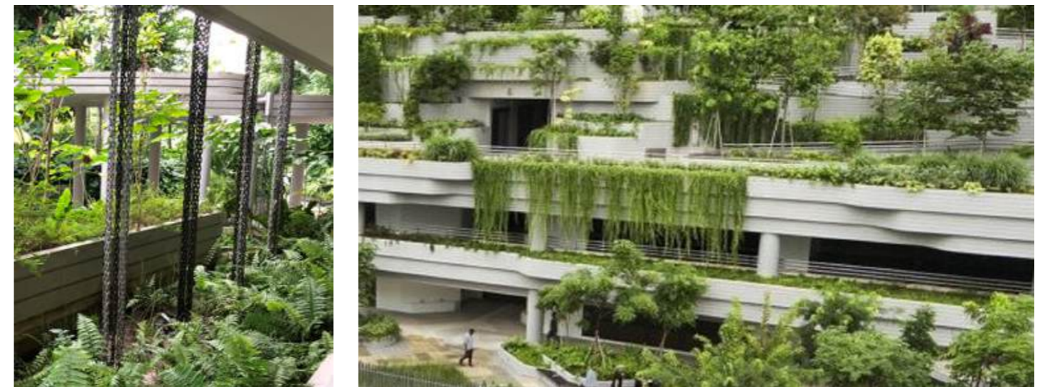
Hình 7.32 (trái) và 7.33 (phải): Các lớp lọc sinh học với các thảm thực vật nằm trên mặt tiền hình thành nên một hệ thống xử lý nước thoát theo chiều dọc của tòa nhà.
