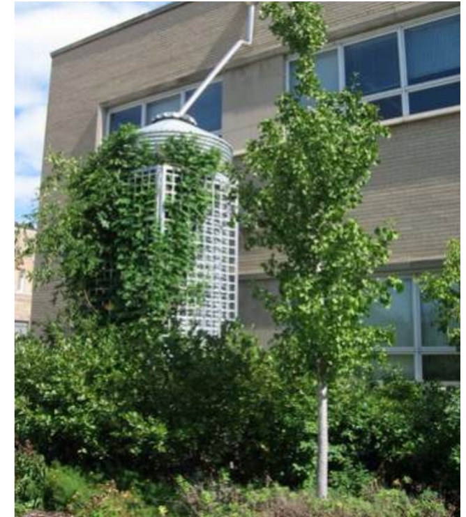
Hình 4.36: Một bể trữ nước mưa dùng cho mục đích thương mại tại Trung tâm Kỹ thuật Xanh Chicago.
