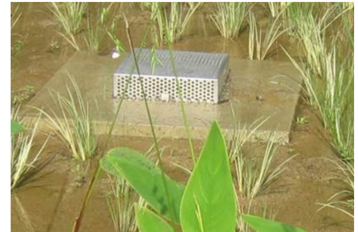
Hình 5.18: Duy trì đĩa phân phối nước trên thảm lọc sinh thái tuần hoàn không bị tắc nghẽn.
