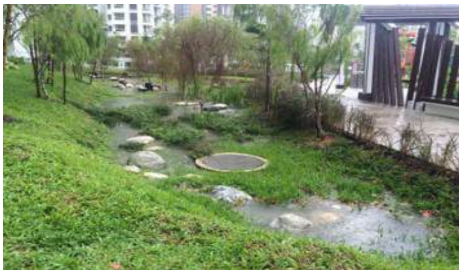
Hình 7.45: Một trong những thảm lọc sinh thái trong khu vực với chức năng điều tiết và lọc nước mưa
