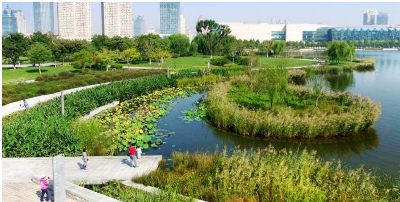
Hình 6.72: Hệ thống thẩm lọc sinh thái tuần hoàn với nhiệm vụ làm sạch nước mưa trước khi chảy ra hồ.
