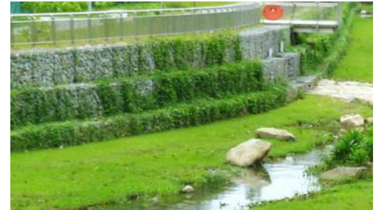
Hình 7.7: Các rọ đá kết hợp cây trồng dọc theo bờ kênh giúp giảm rủi ro xói mòn trong các trận lũ lụt.
