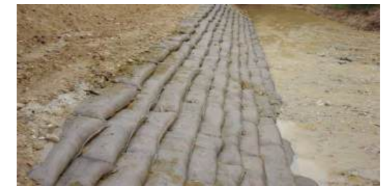
Hình 4.73: Các túi địa kỹ thuật được lắp đặt hoàn tất
