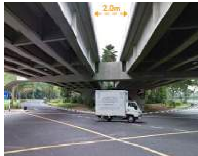
Hình 4.50 (trái) và 4.51 (phải): Một khoảng rộng tối thiểu 2.0m có thể được cung cấp giữa hai cầu vượt song song. Khoảng này cho phép cây lớn, cây cọ hoặc cây bụi có thể được trồng bên dưới cầu vượt
