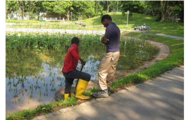
Hình 5.16: Công nhân cào cát trên bề mặt lớp lọc
