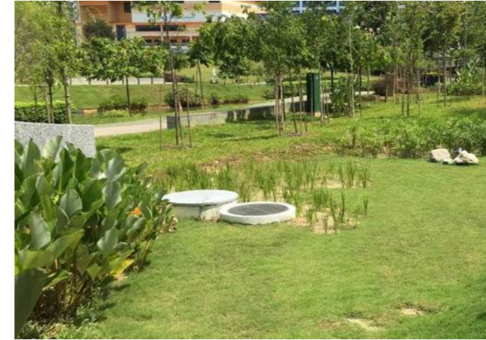
Hình 4.13: Hồ tràn nước mưa điển hình
