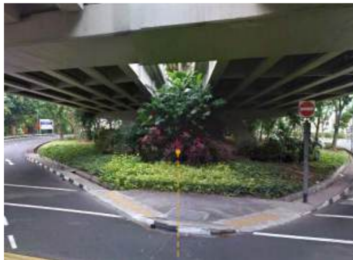
Hình 4.50 (trái) và 4.51 (phải): Một khoảng rộng tối thiểu 2.0m có thể được cung cấp giữa hai cầu vượt song song. Khoảng này cho phép cây lớn, cây cọ hoặc cây bụi có thể được trồng bên dưới cầu vượt
