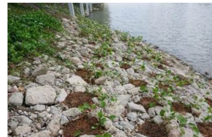
Hình 7.26: Hình ảnh thể hiện hệ thống rải đá và giâm cành và hệ thống gia cố bờ nhân tạo ven bờ hồ Jurong.
