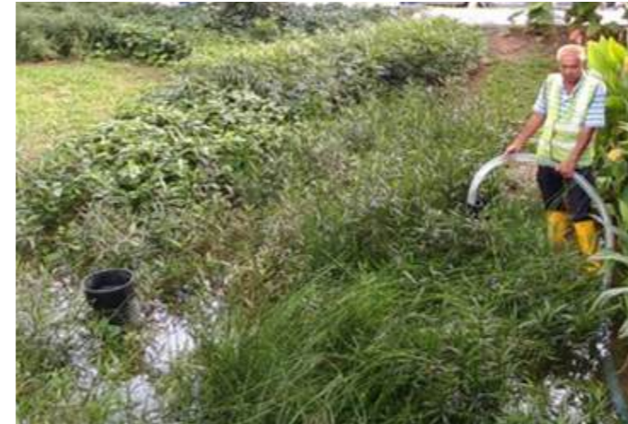
Hình 5.15: Công nhân xả nước bằng ống nước mềm
