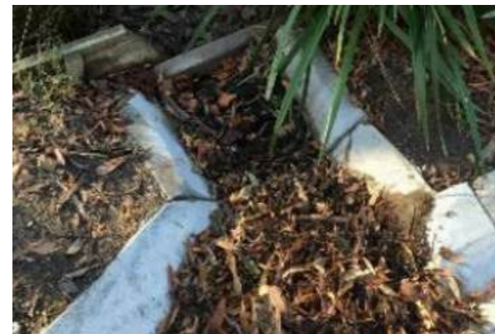
Hình 5.19: Ống nước đầu vào bị tắc nghẽn
