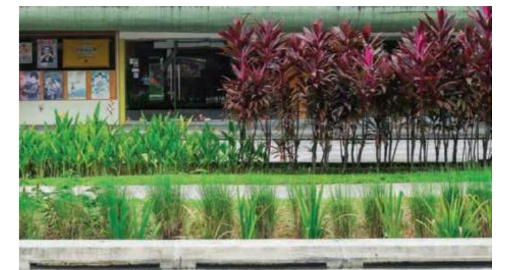
Hình 4.22: Kênh lọc nước sinh thái ven đường tại khu dân cư Faber Hills
