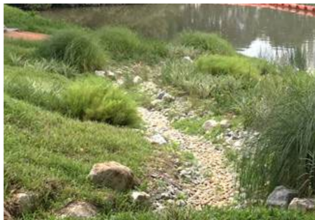
Hình 7.22: Các kênh dẫn nước sinh thái được dung để thoát nước trong khuôn viên Jurong Lake Gardens West thay cho kênh thoát nước bê tông
