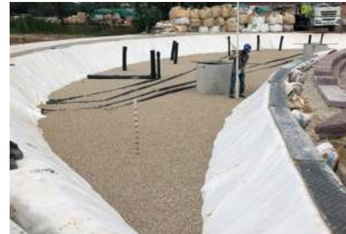
Hình 5.5: Lắp đặt lớp trung gian
