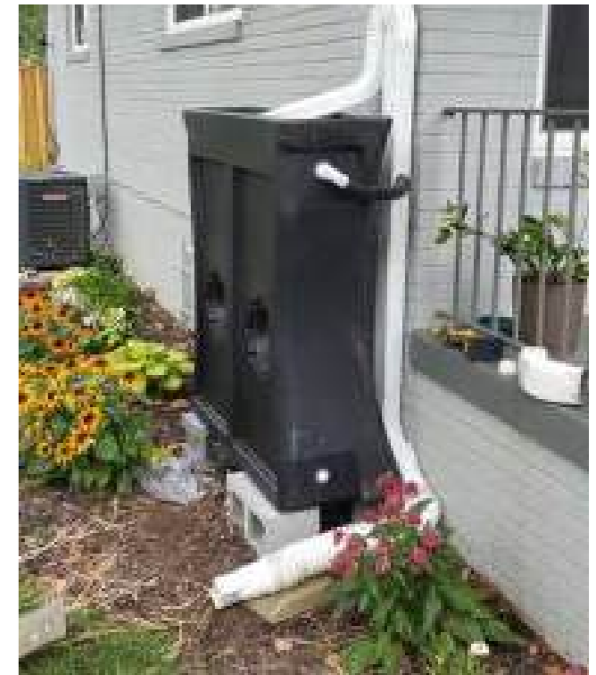
Hình 4.37: Một thùng chứa nước mưa được lắp bên cạnh nhà
