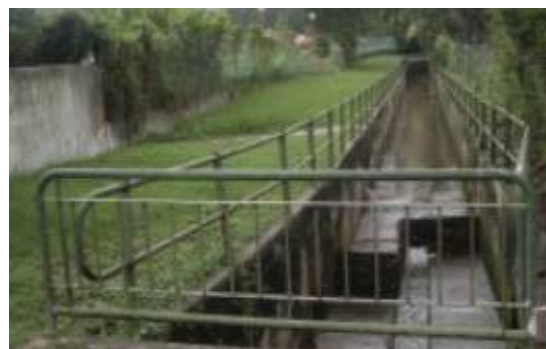
Hình 7.23: Kênh dẫn nước bê tông ban đầu
