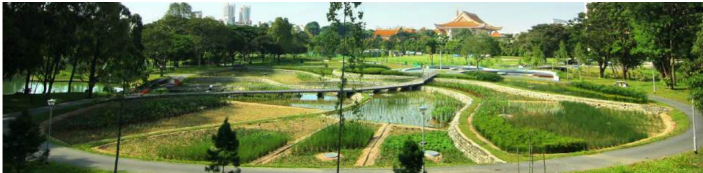
Hình 7.5: Hệ thống thẩm lọc sinh thái tuần hoàn tại công viên Bishan-Ang Mo Kio. Nước mưa được luân chuyển qua các thảm thực vật và 4 bậc giúp thanh lọc nước sông và nước thoát.
