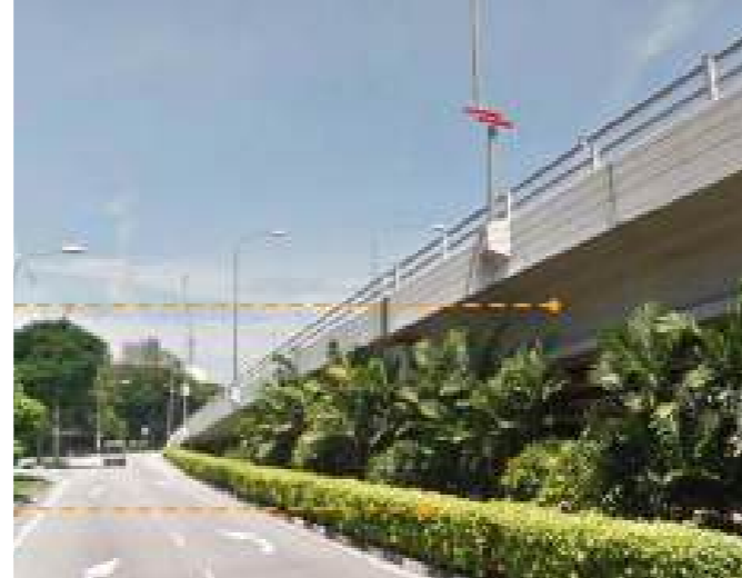
Hình 4.49: Các luống cây rộng tối thiểu 2.0m có thể được bố trí ở hai bên cầu vượt đường bộ và các công trình trên cao khác
